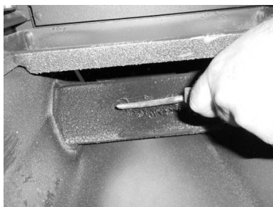
Figura 28 - Limpeza do interior da caldeira a água
