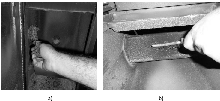
Figura 25 - Limpeza do interior da caldeira a água
