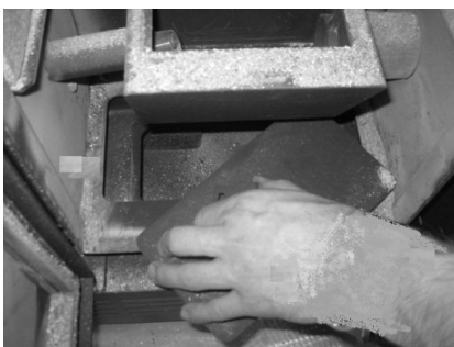
Figura 31 - Limpeza do interior da caldeira
