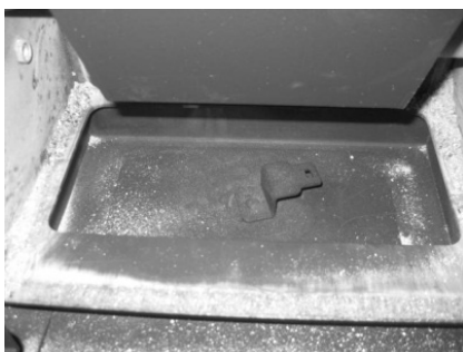
Figura 31 - Limpeza do interior da caldeira
